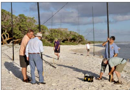
Es wurden alle Antennen vor Ort konfektioniert und mit 17 Glasfibermasten aufgebaut.
