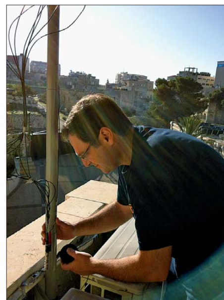
Peri, E44PM, beim Errichten der Antennenanlage in der Pension des Bethlehemer Waisenhauses Fotos: HE9DAG (2), HB9IQB
