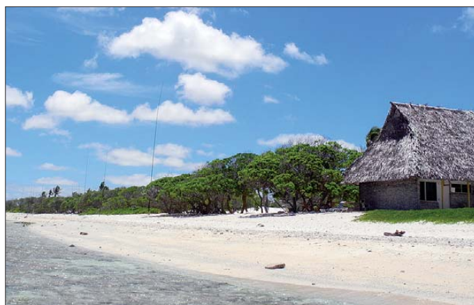
Der Küstenstreifen mit den Hütten des Captain Cook Hotels (CCH); in der Mitte erkennt man die 160-m-Vertikalantenne.
